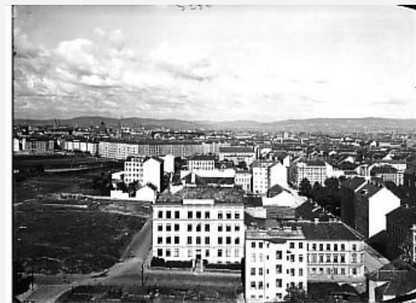
Gebäudeansicht der Schrankenberggasse 32 aus Richtung der Ankerbrotfabrik Quelle: https://www.wien.gv.at/actaproweb2/benutzung/image.xhtml?id=pf3acpcOFRoRPbs/N2i3jOM0+8OkdD4Jp25sfgC2ACs1
